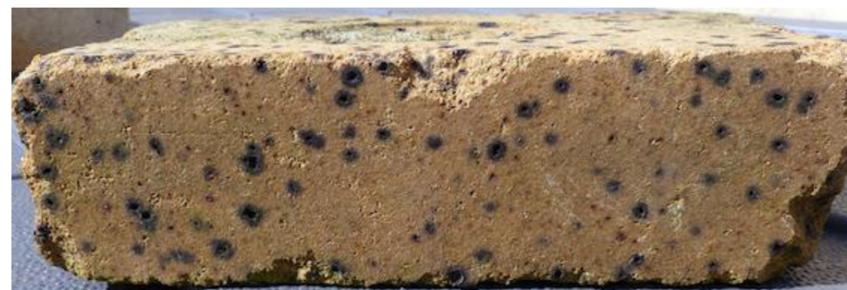
20. Widok przykładowej cegły nakrapianej w wyniku przebarwień
