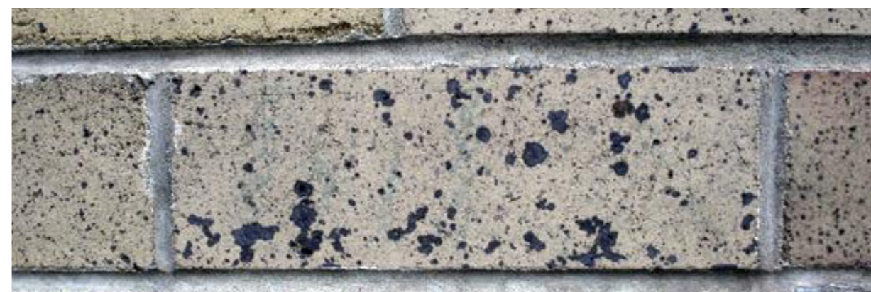
19. Cegły z plamkami, wzór ciemnych plamek na powierzchni cegły licowej spowodowany tlenkami żelaza lub manganu. 38
