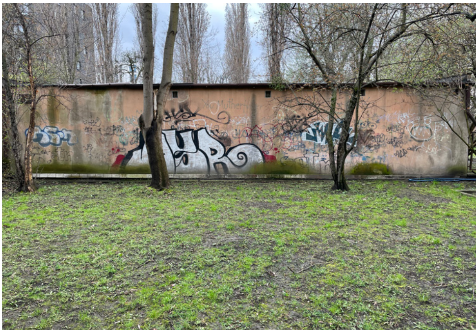
88. Tylna ściana garaży wolnostojących
