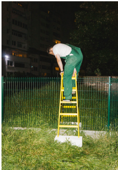
72. „Wejdz” – montaż na ogrodzeniu
