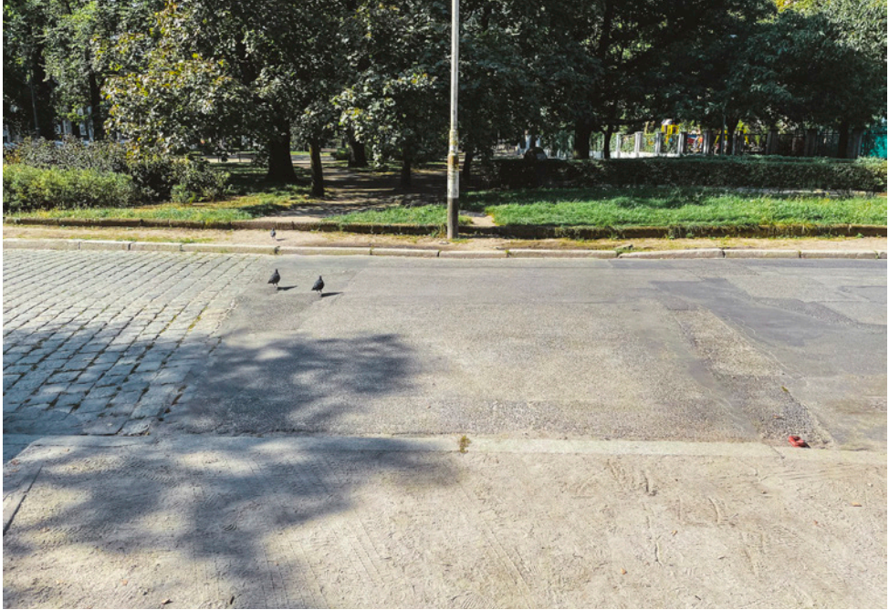
82. Droga przecinająca skwer przy ul. Prusa
