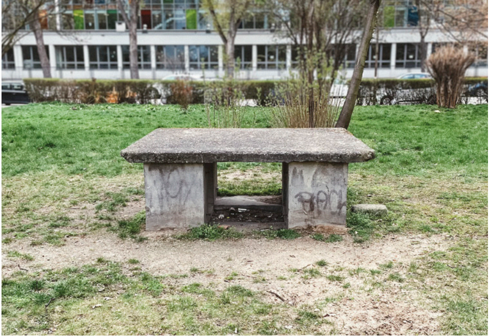
43. Nieczynna czerpnia powietrza z piwnicy pełniącej rolę bunkra na jednym z osiedli mieszkaniowych przy ul. Górnickiego
