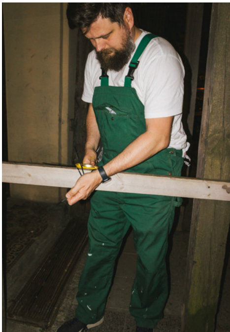
96. „Posprzątaj” – montaż na drewnianej konstrukcji
