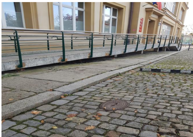
Widok hydrantu zewnętrznego, podziemnego przy Placu Polskim
