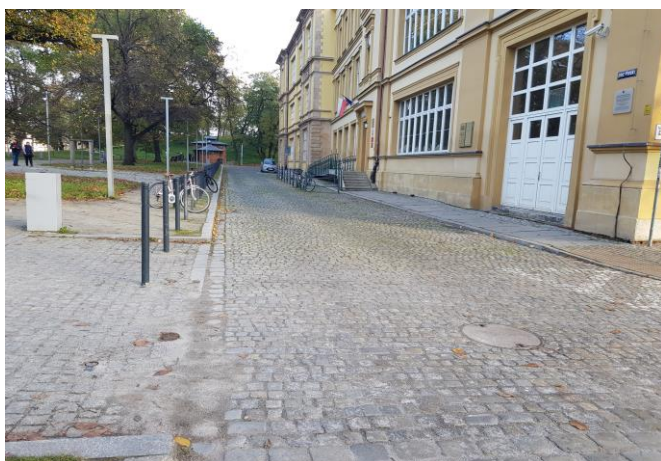
Widok drogi pożarowej do budynku A
