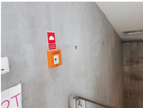
Elementy systemu oddymiania - klapa dymowa, ręczne przyciski uruchamiające
