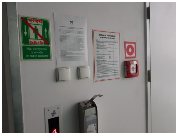
Elementy systemu SSP – czujki i ręczne ostrzegacze pożaru -ROP
