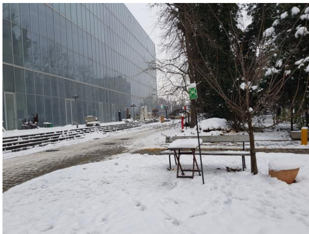
Widok drogi pożarowej do budynku CSU CI z widocznym oznakowaniem terenu ewakuacji
