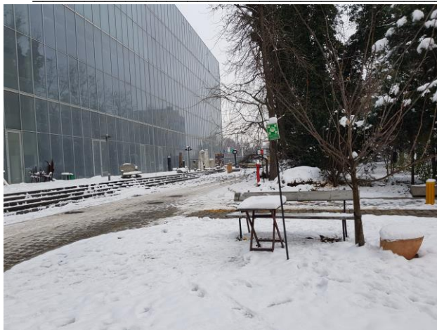
Widok drogi pożarowej wzdłuż budynku CSI CI z widocznym oznakowaniem terenu ewakuacji
