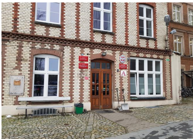
Główne wejście do obiektów ASP, tzw. "Stare Traugutta"
