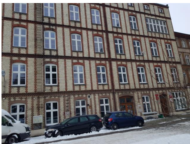
Budynek A – centralnie usytuowany, główny budynek kompleksu.
