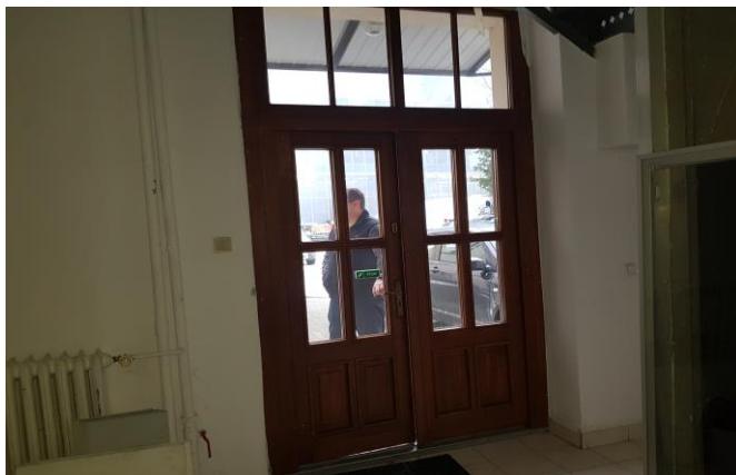
Widok wyjść ewakuacyjnych z budynków
