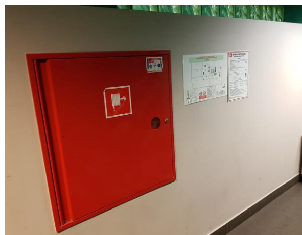
Podręczny sprzęt gaśniczy - hydranty z wężem pólstywnym 25 mm i gaśnice
