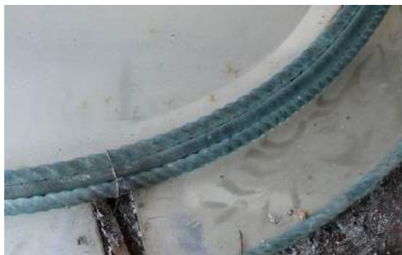
Fot. 54. Widoczne fazowanie krawędzi tafli centralnej, fot. N. Moszak
