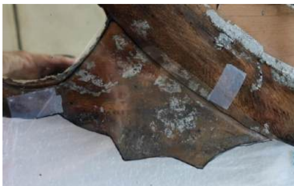
Fot. 96. Montaż izolującej folii poliestrowej, MJG 36s, fot. N. Moszak
