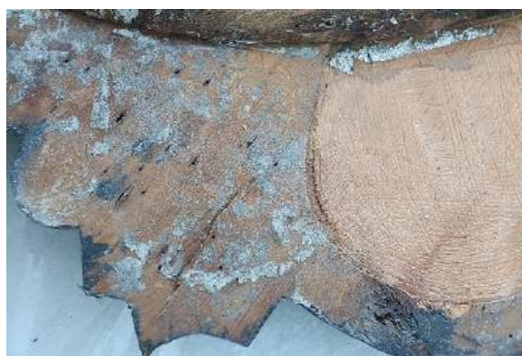
Fot. 70. Widoczna różnica w kolorze drewna przykrytego szczelnie taflą szkła (drewno jasne po prawej) oraz z dostępem czynników wpływających destrukcyjnie (drewno ciemniejsze po lewej)
