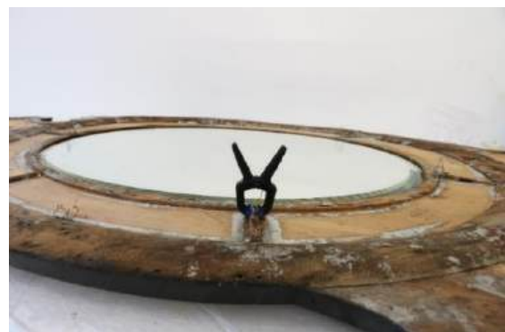
Fot. 94. Klejenie drewna na licu ramy zwierciadła, MJG 36s, fot. N. Moszak
