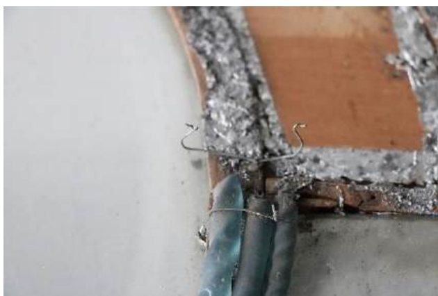
Fot. 48. Montaż szklanych prętów za pomocą skręconych wokół siebie drucików, zamontowanych do podłoża za pomocą gwoźdźca, fot. N. Moszak
