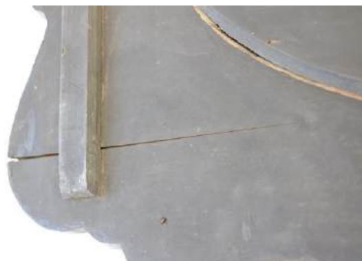
Fot. 60. Pęknięcie drewna, MJG 36s, fot. N. Moszak
