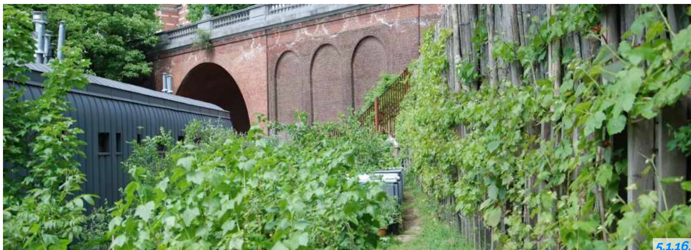
Fot.5.1.16. Widok na most Couronne z Ogrodu Gray- Couronne.
