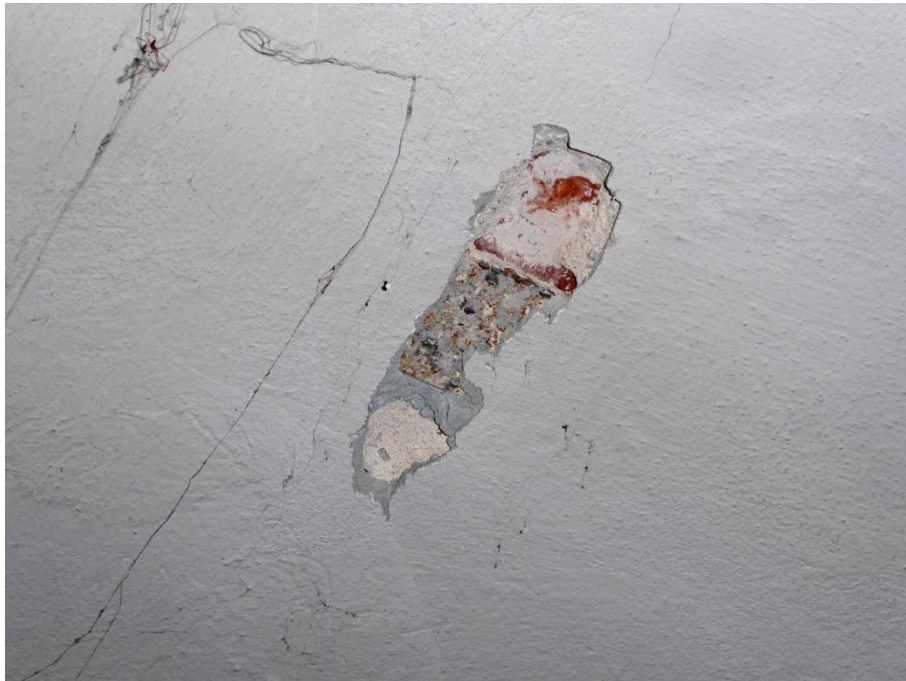
Fot. 6. Odkrywka stropu Kleina; widoczne są: stopka belki stalowej oraz fragment płyty ceramicznej Kleina
