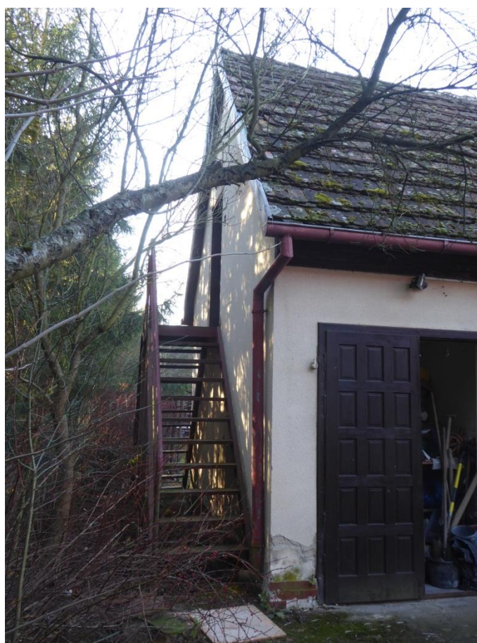
Fot. 8. Schody stalowe od strony południowej budynku
