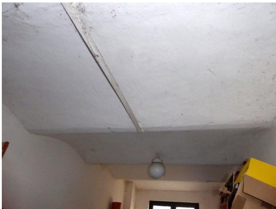
Fot. 7. Strop odcinkowy na belkach stalowych
