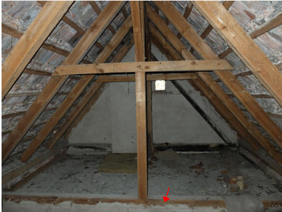
Fot. 9. Więźba dachowa krokwiowa z kalenicą podpartą słupami; słupy opierają się na masywnych belkach drewnianych ponad poziomem stopu (oznaczono strzałką)
